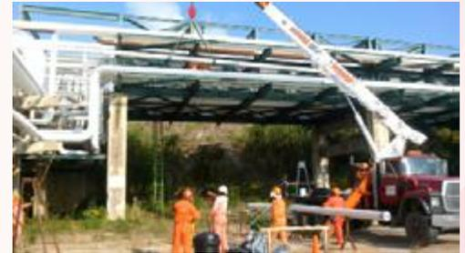
La segunda etapa requirió de trabajos combinados de ingeniería civil e ingeniería mecánica para la realización de 50 mochetas distribuidas a un costado del acceso a la planta donde se ahogó en el concreto una placa para realizar las soldaduras de las guías que cada tubo requiere.
